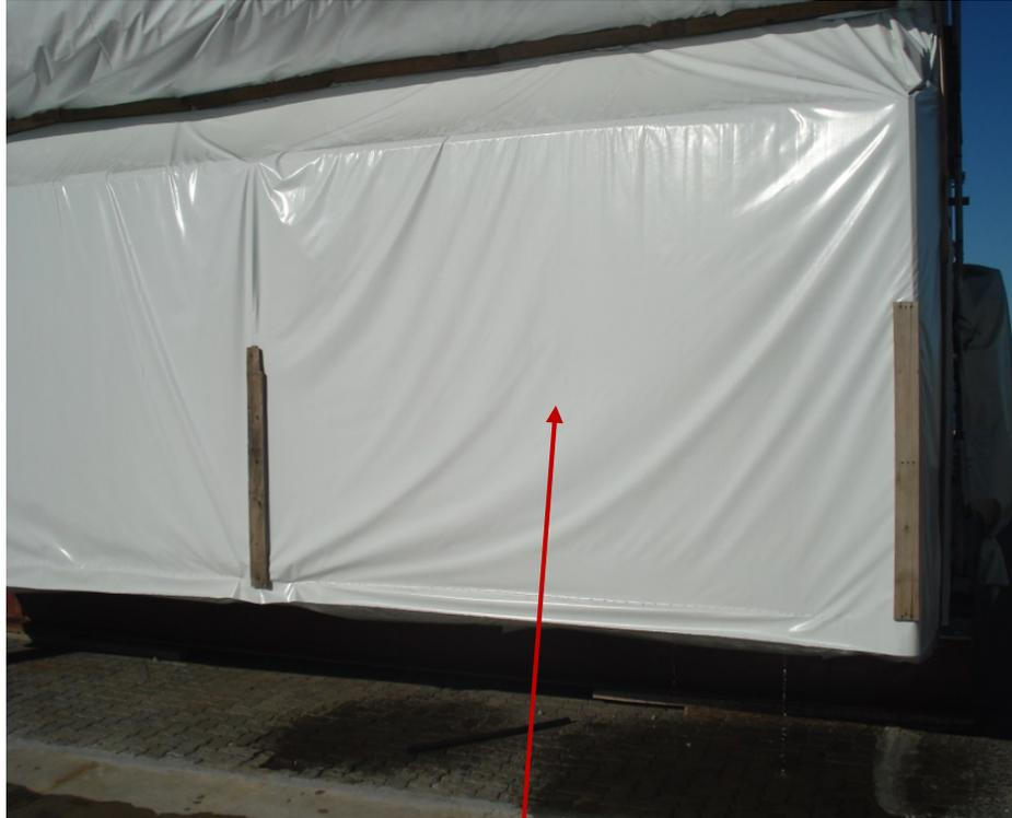
Aislamiento de las entradas de aire con la aplicación de la película Termoencilible anti UV.
