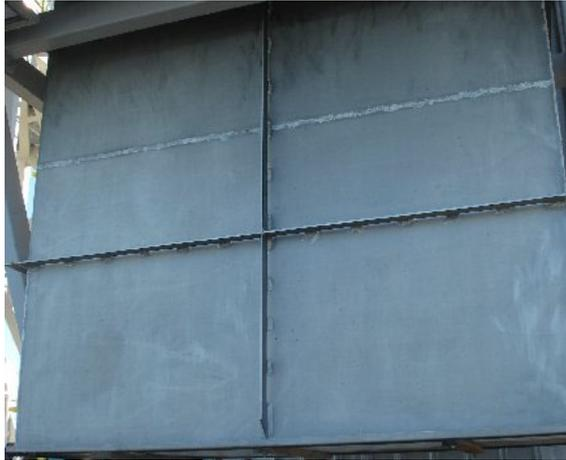
Descontaminación del acero inoxidable (soldadura y superficie), expuesto a la intemperie con **LQS 500**. Protección superficial con **MV Oil® 807** y **MV Skin** en las esquinas de acumulación.
