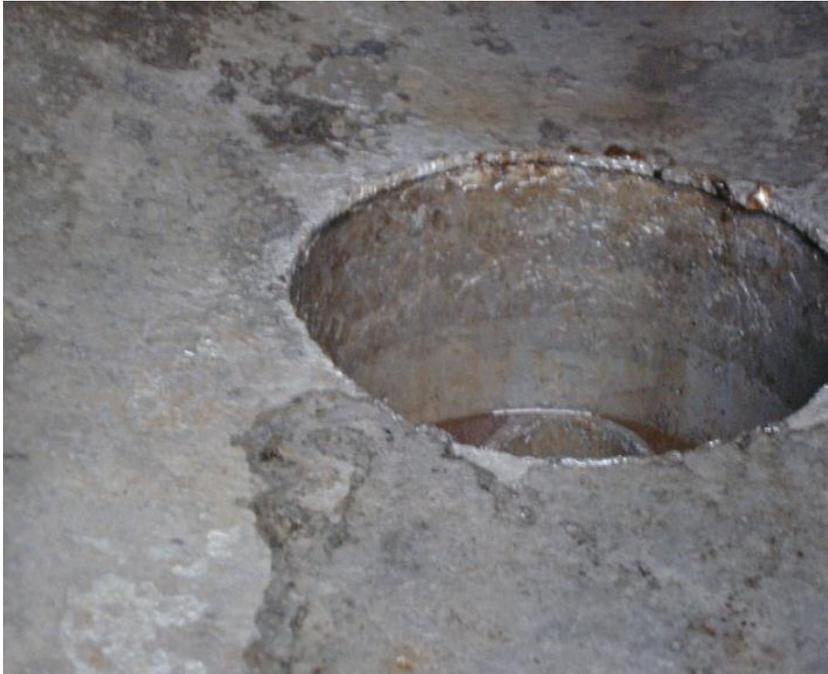
Con este procedimiento fue posible la retirada de las Escamas y remoción de la oxidación, cuando el decapante estuvo en contacto directo con el metal.
