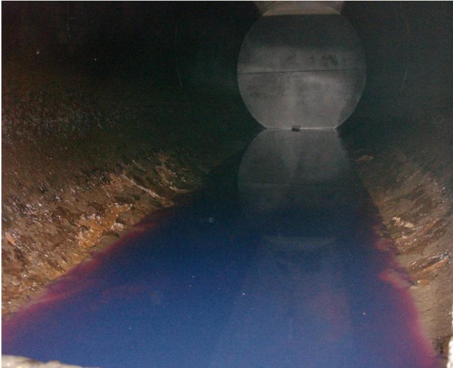
Limpieza química (decapado de tanques), utilización del decapante ligero ácido **LQS 500 30%** y pasivación con el producto **MV Aqua® 350** como neutralizador aditivado con V-active al 10%.
